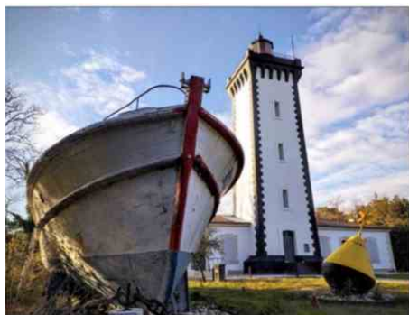
Contraste saisissant entre la vedette Matelier, qui a besoin d'une rénovation complète, et le nouveau musée du phare de Grave, qui connaît un succès mérité.
