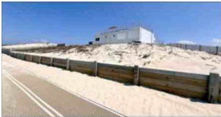
Des modulaires provisoires ont été installés sur le nouvel emplacement. PHOTOSJDM
