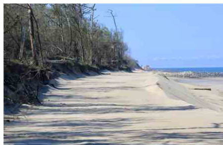
Ci-contre, la plage sud a retrouvé une « banquette » de sable permettant de gommer temporairement un niveau d'érosion très marqué dans ce secteur de la station, comme ci-dessous au mois de février dernier. Photos J. L.
